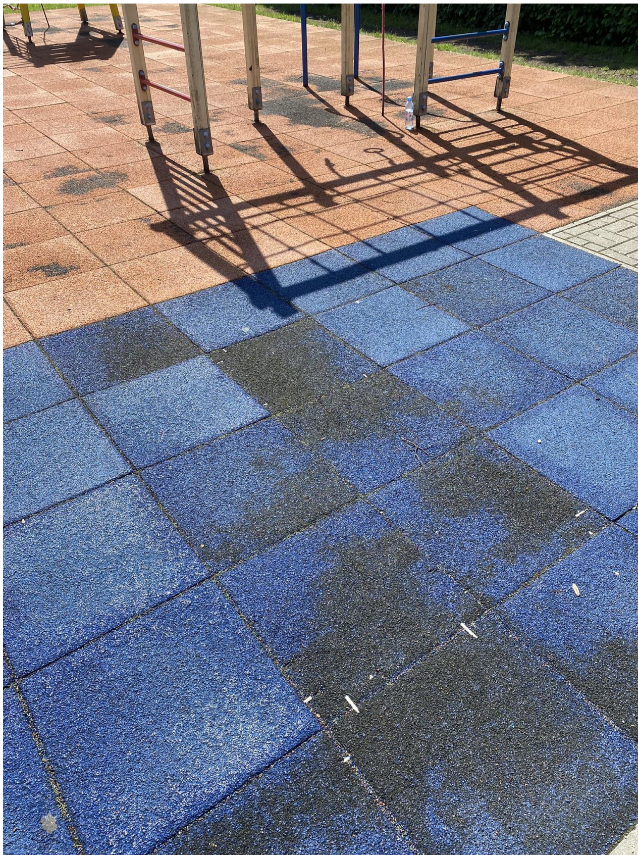
Rys. 2- aktualna nawierzchnia placu zabaw (przetarcia i wystające elementy mocowania nawierzchni)
