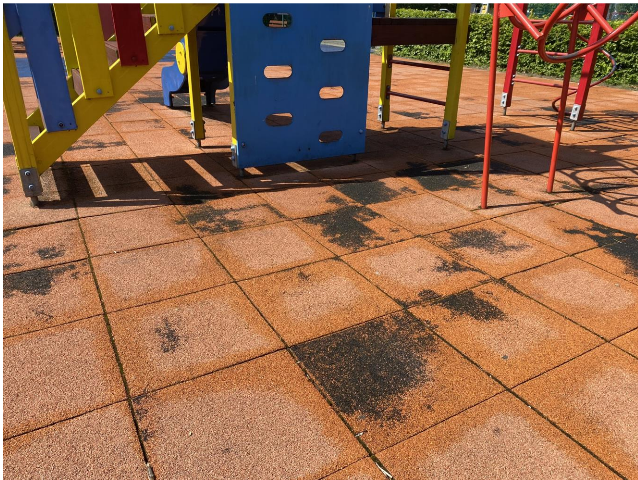
Rys. 7- jeden z elementów placu zabaw (stan aktualny) wraz z widoczną nawierzchnią.
