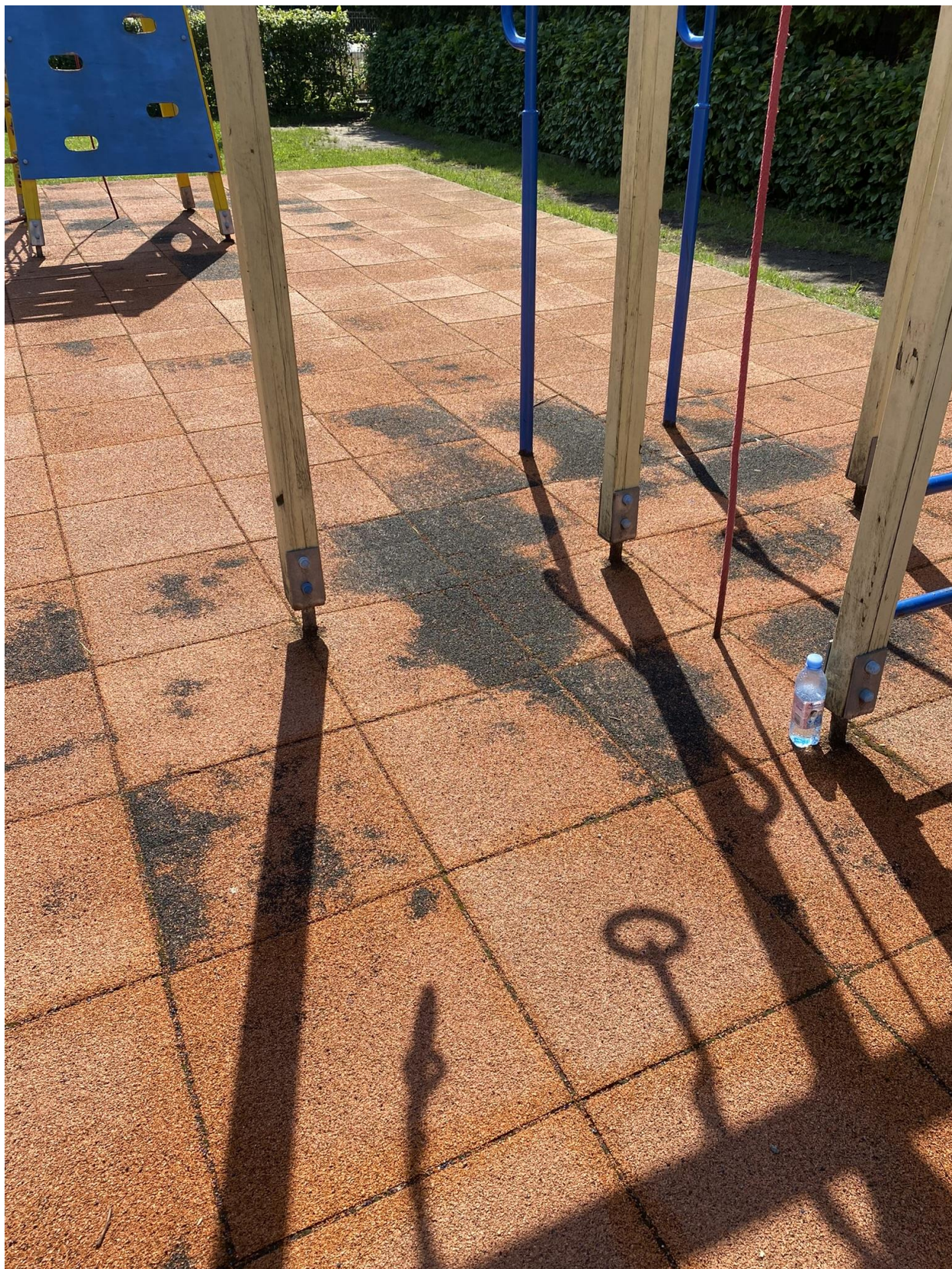
Rys. 4- nawierzchnia i dolna część konstrukcji tworzącej plac zabaw.
