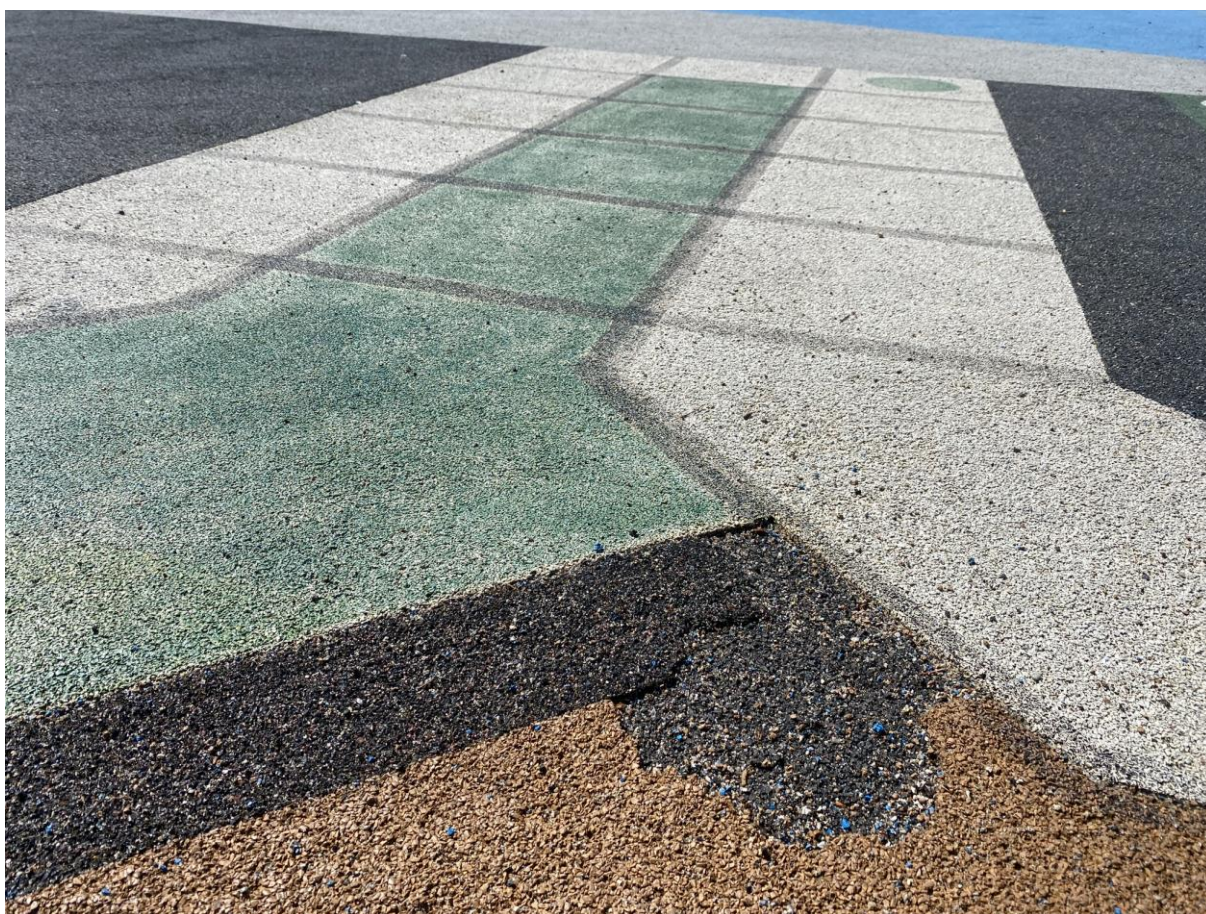
Rys.1- aktualna nawierzchnia placu rekreacji
