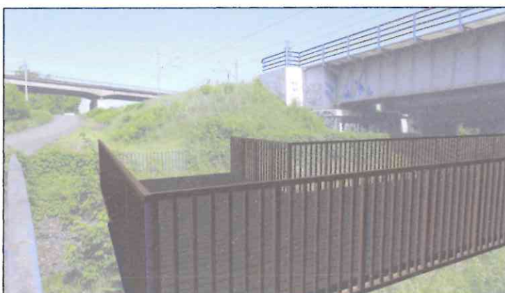
WYJŚCIE KŁADKI NA UL. ZA CYBINĄ
